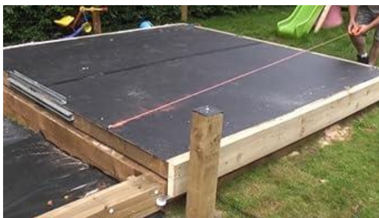
Slika 23. Postupak dobivanja ravne linije pomoću užeta i krede u prirodi
