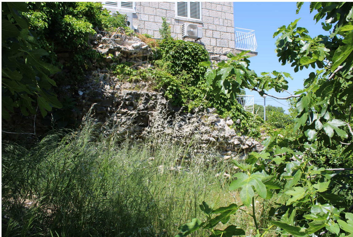
Slika 3. Ostaci antičkog vodovoda u ulici Kneza Domagoja južno do stare jezgre Cavtata 3
