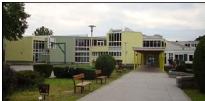
Slika 8: OŠ Dubovac u Karlovcu - poslije energetske obnove
